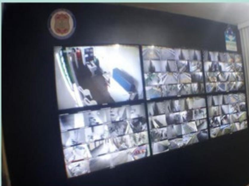
Conjunto de 06 monitores de 49 polegadas fixados na parede em frente a mesa dos operadores. Cada monitor terá 16 imagens de câmeras.
